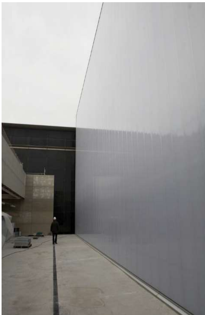
T2A. Aeropuerto de Barcelona. Terminal Intermodal .Panel 2540-4 de 13,5 m. de alto Monocolor Opal. Arqto.: José María Casadevall
