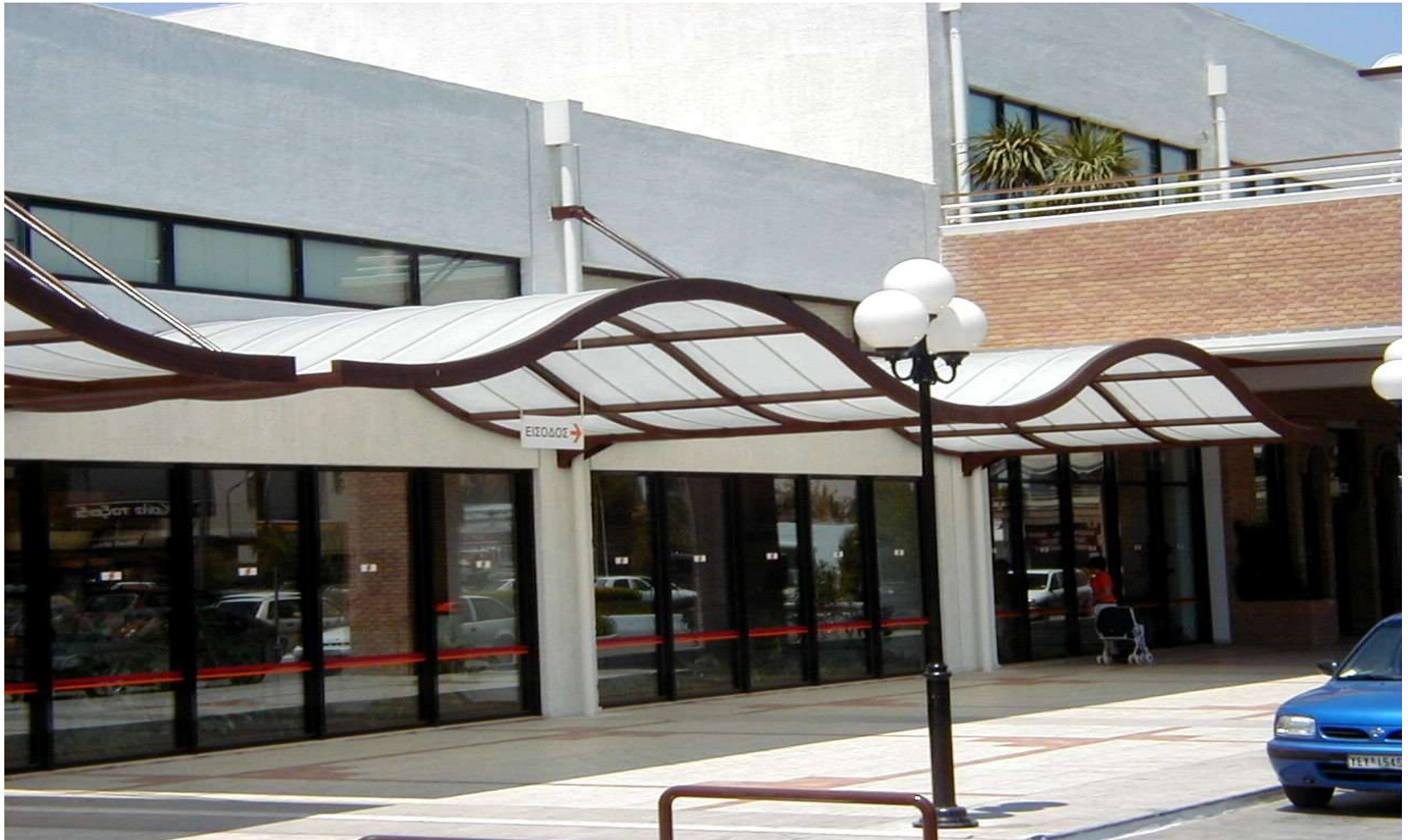
Marquesina acceso Centro Comercial
