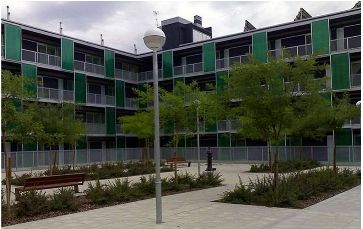
Mamparas balconadas en Pardinyes (Lérida) Arqta: Coll-Leclerc. Obra. Premio de Arquitectura.
